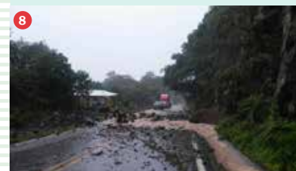
8 PROTECCIÓN CIVIL REPORTA PELIGROSO DESLAVE SOBRE LA CARRETERA CONCORDIA-EL PALMITO.
