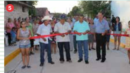
5 INAUGURAN CALLE EN TEPUXTA Y ARRANCA OBRA DE ALCANTARILLADO.
