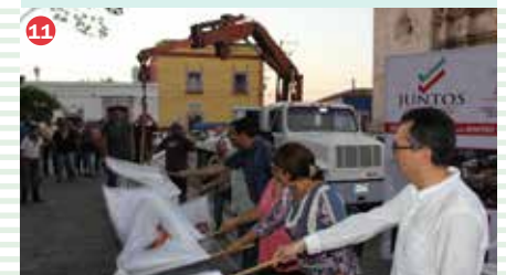
BANDERAZO DE ARRANQUE PARA REMODELACIÓN DE LA PLAZUELA Y QUIOSCO DE CONCORDIA.
